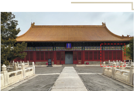
武英殿外立面(虚线框内为露房)
