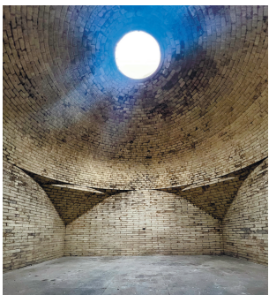
浴德堂浴室内容(局部)
