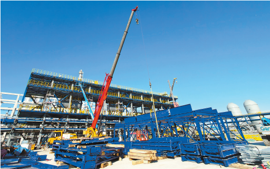
燕山石化南港橡胶项目施工现场。
