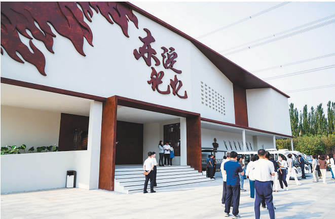
东淀记忆主题展馆由村内闲置建筑改造提升,占地3200平方米。 记者 潘立峰 摄
