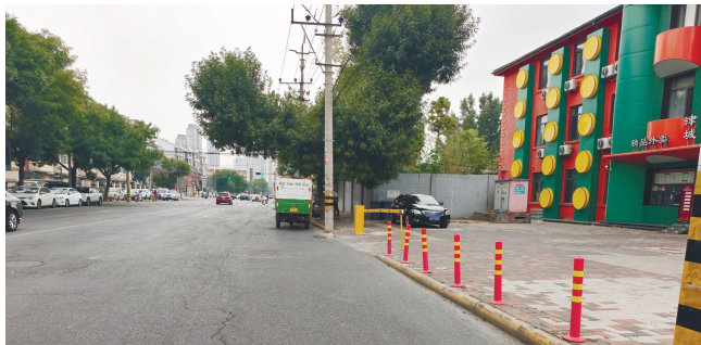
津城臻宴门前空地上安装分道柱(整改前)。
