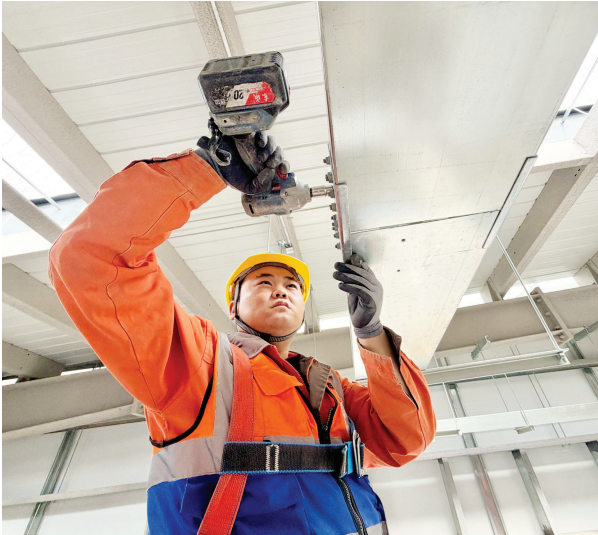
中建三局建设者在中汽中心新能源检验中心二期项目现场施工。
