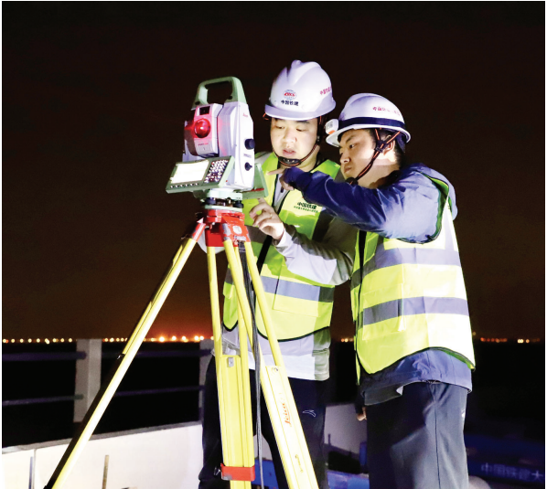
中国铁建大桥局设计研究院工作人员在津雄高铁项目现场进行夜间线路勘测。
