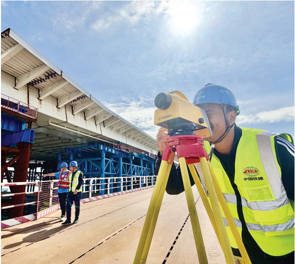
中铁十八局建设者坚守在西中环快速路跨海河桥工程现场。
