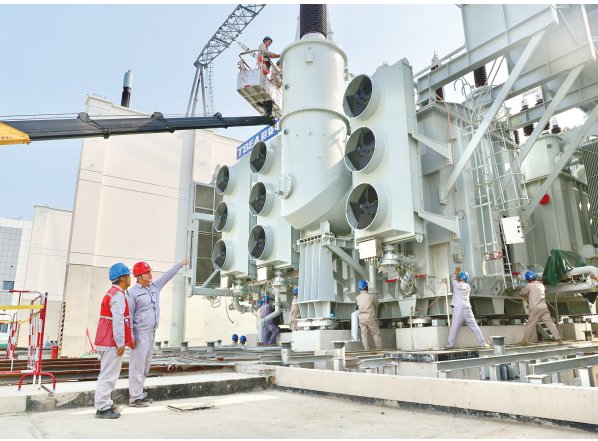
天津北1000千伏变电站工程现场，施工人员正加紧进行设备安装。 记者 孙志强 摄
