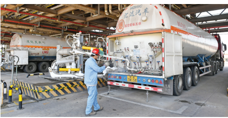
图为槽车充装液化天然气。 记者 周伟 摄
