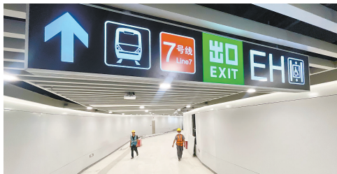
地铁肿瘤医院站换乘通道建设收尾,即将实现3条线地下站内换乘。 记者 张磊 摄
