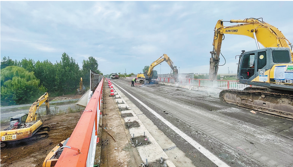
津榆公路跨京津塘高速立交桥实施拆除作业。
