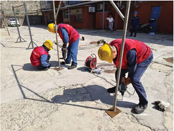
施工人员正在安装晾衣架。
