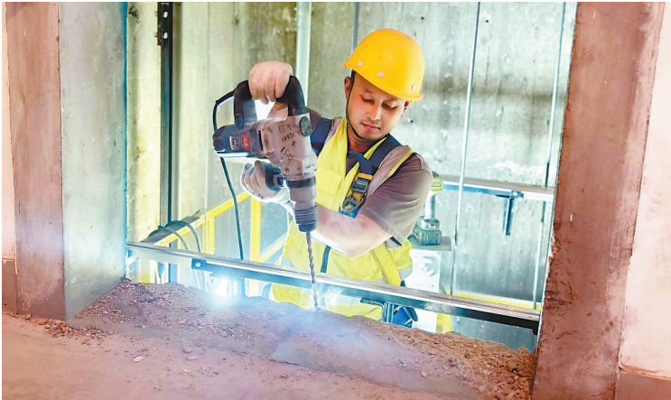
碧华里错峰施工的第二部电梯正在进行收尾,预计本月底完成安装。
