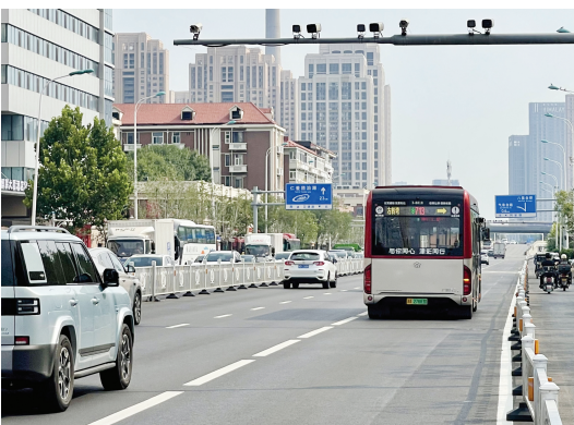
已更换为白色标线的公交专用道。 记者 张磊 摄于津津路
