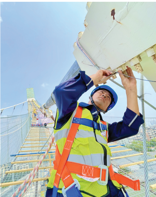
施工人员在高空对桥体进行维修测量。 记者 张磊 摄
