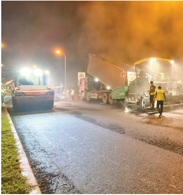
近日,汉港线津南段民心工程养护现场灯火通明,经过前期的铣刨作业,目前开始进行表面层最后一公里的铺油作业,完工后将提升行车舒适性。
