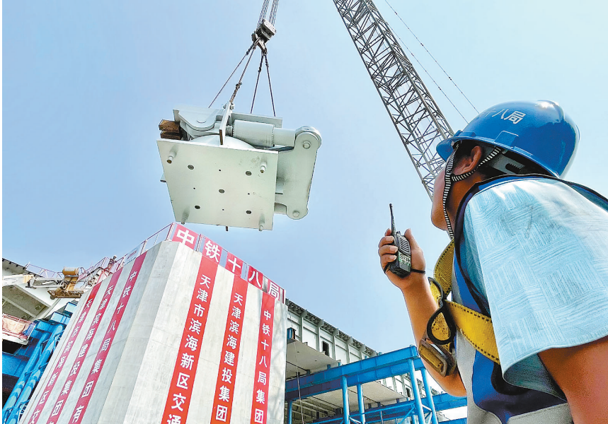
昨天,随着重达64.5吨的摩擦摆支座精准落位,滨海新区西中环快速路跨海河桥工程转入拱部施工阶段。 记者 张磊 摄
