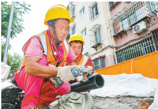
安华里小区燃气管网改造现场。 记者 吴迪 摄
