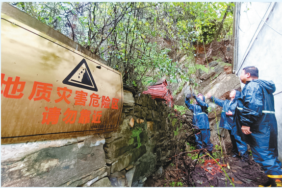
▲ 蓟州区穿芳峪镇新水场村组织专人，成立防汛队伍，上山对各地质灾害点进行巡查排查，并清理各排水沟中的垃圾杂物。图为防汛应急队员在地质灾害点排查隐患。 记者 钱进 摄
