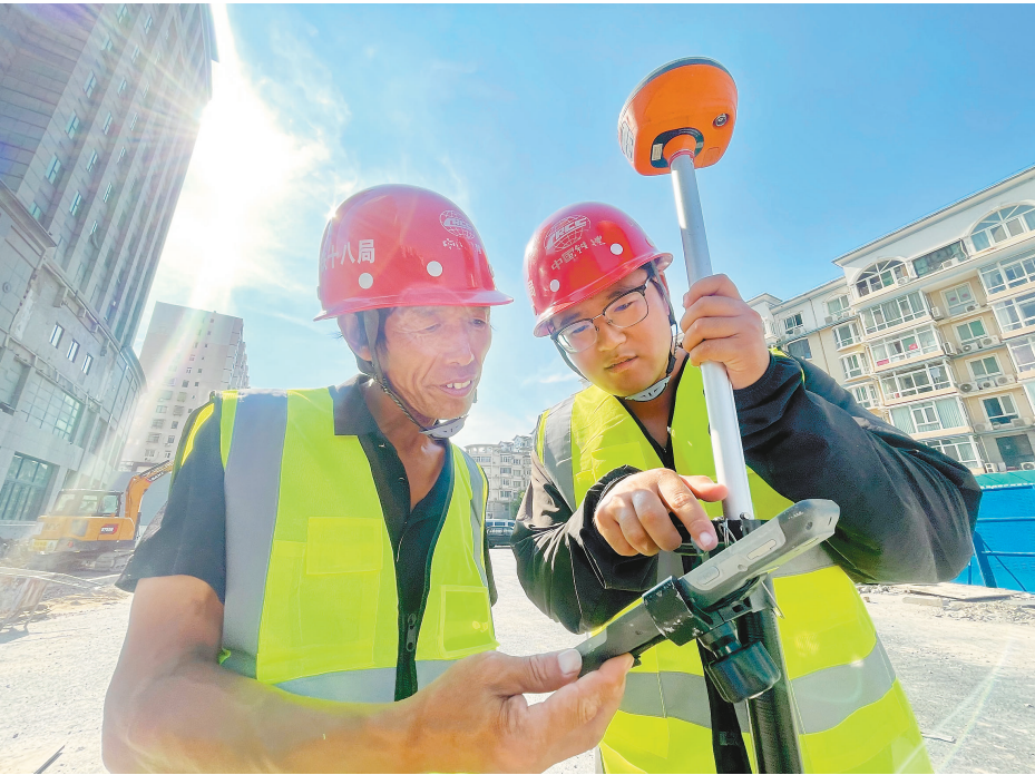
昨天,中铁十八局施工人员在地铁8号线人民公园站外的永安道(汕头路至广东路)进行道路恢复施工,该路段预计本月初恢复通行。
