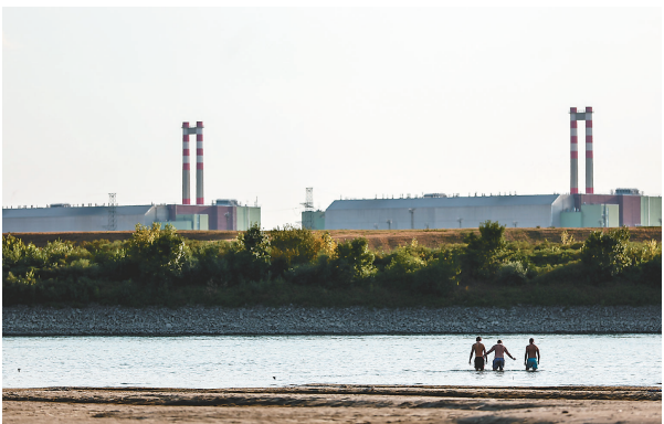
8月2日,在匈牙利多瑙圣拜奈代克,居民在多瑙河中纳凉,多瑙河对岸是保克什核电站。由于多瑙河水位降至历史新低,冷却水源不足,该国唯一的核电站——保克什核电站将首次完全关闭。 新华社发
