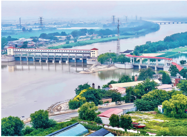
屈家店枢纽全景图。
