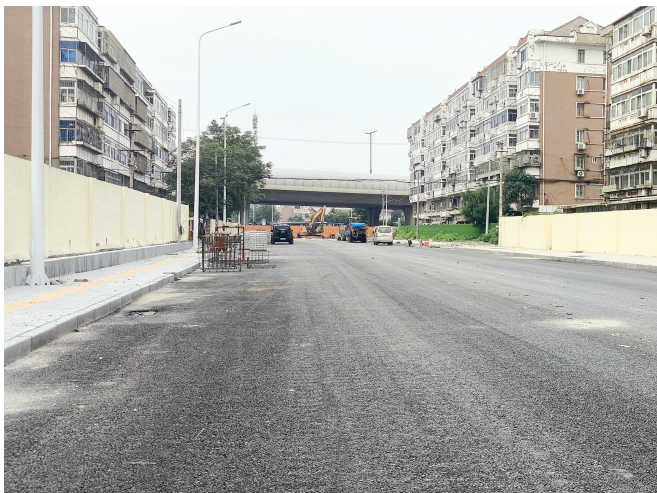
东丽区方山道(程万路—昆仑路)工程即将竣工,该条道路建成后可为周边居民提供一条西行直达快速路昆仑桥的便捷通道,可有效缓解津滨大道通行压力。
