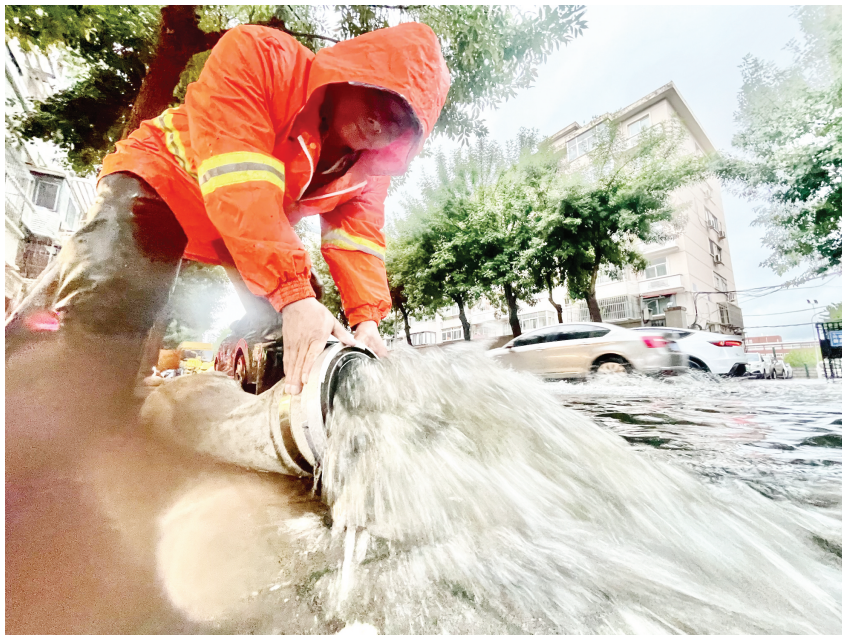
7月7日,我市中心城区突降暴雨,和平区排水所工作人员在电台道排水。
