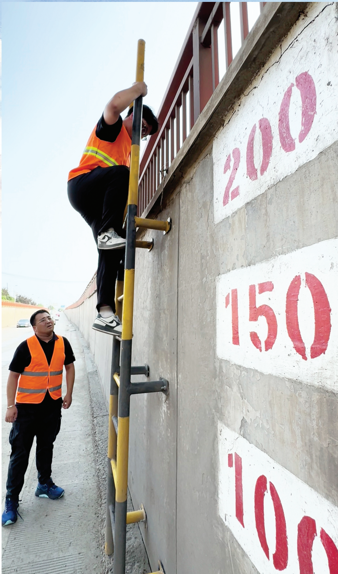
为市民汛期出行增添安全屏障,市公路中心对克黄线唐通地道、葛万线葛万地道、津沽线天津大道地道以及津芦公路大毕庄地道、津沽地道等5处易积水公路地道加增了12个应急逃生爬梯,以备涉水者逃生时使用。
