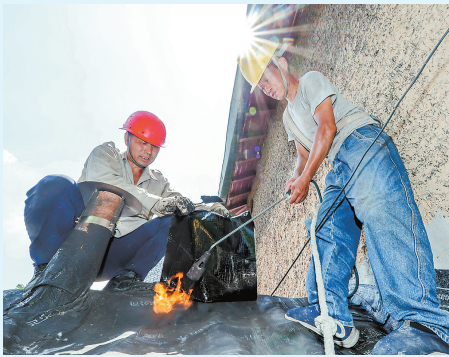
昨日,五大道房产管理部工作人员顶着烈日,在安裕里一处房屋铺设油毡、修缮屋顶,及时处理房屋渗漏隐患。图为工作人员铺设油毡。 记者 吴迪 摄
