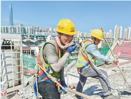
连日来,在滨海新区老旧小区改造现场,中铁十八局五公司的建设者们坚守一线,确保工程如期完工。图为中铁十八局五公司施工人员在胜阳里小区作业。 记者 张磊 摄
