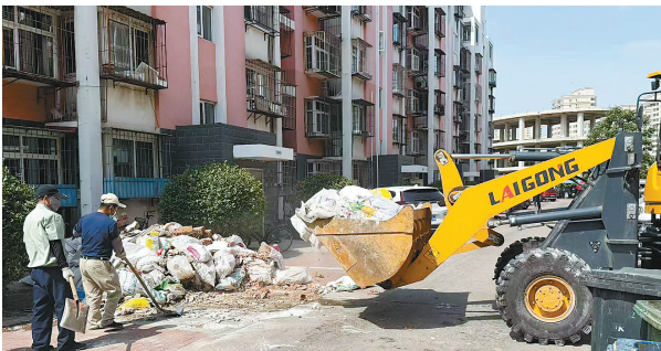
老旧小区施工现场。
