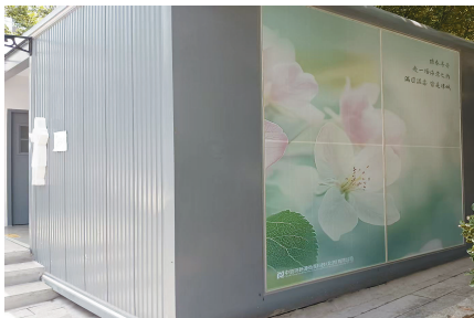
全彩光伏零碳公厕外景。
