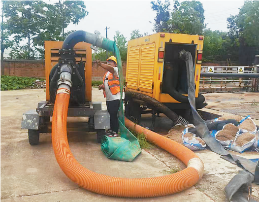
工作人员增设排水设施,开展应急抢修作业。 照片由滨海新区排灌事务中心提供
