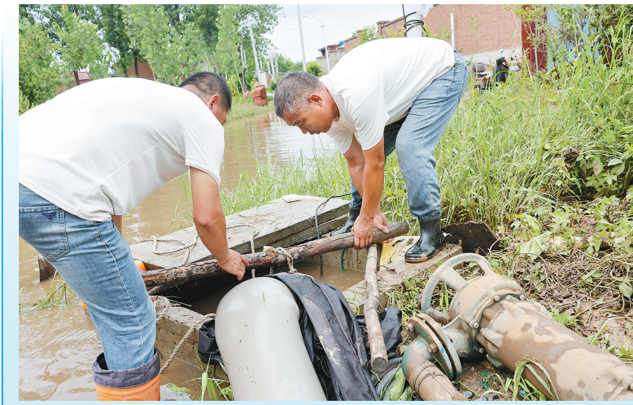
昨日雨后,蓟州区侯家营镇南周庄村因地势低洼积水严重,工作人员持续开展排水作业。 记者 吴迪 赵建伟 摄
