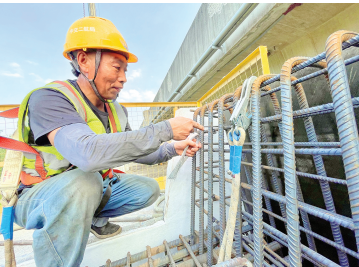
京津塘高速公路(天津段)改扩建工程第三标段作业现场。 记者 张磊 摄
