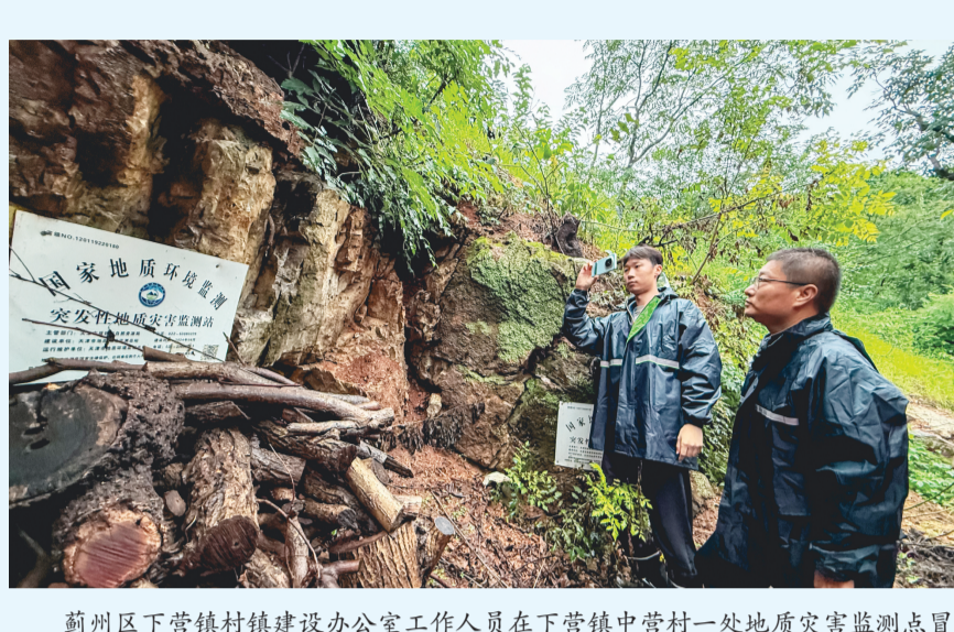
蓟州区下营镇建设办公室工作人员在下营镇中营村一处地质灾害监测点冒雨巡查。
