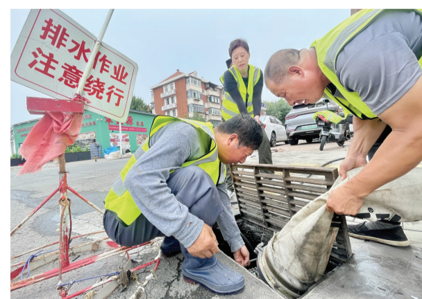
昨天，沈洪娜（中）带领抢险队员清理雨水井。记者 张磊 摄
