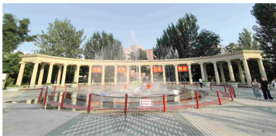
整修完毕焕然一新的喷泉。
