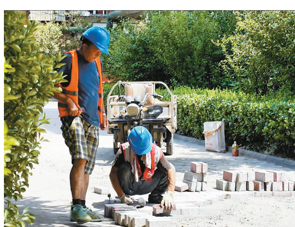
改造施工现场。
