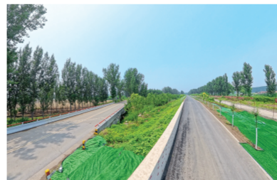
青向洼蓄滞洪区提升改造工程主体完工。记者 赵建伟 摄
