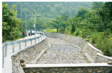
被列入蓟州区山洪沟治理二期工程的沟河北沟完成治理。记者 孙志强 摄
