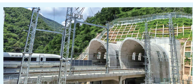
6月30日,中铁十二局电气化公司参建的西十高铁项目全线正式开通,以精工建造赋能智慧高铁,用稳定畅通的全域5G网络,为秦楚建通架设“生命线”。图/文 谢佳璐
