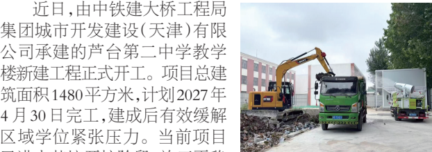
近日,由中铁建大桥工程局集团城市开发建设(天津)有限公司承建的芦台第二中学教学楼新建工程正式开工。项目总建筑面积1480平方米,计划2027年4月30日完工,建成后有效缓解区域学位紧张压力。当前项目已进入基坑开挖阶段,施工平稳有序。项目部将科学统筹施工计划,严抓安全、质量、进度管控,高标准推进工程建设,全力保障项目如期交付,以匠心精品助力宁河基础教育提质发展。通讯员 宋杉函
