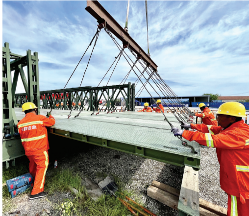
在断桥断路演练中,市公路应急处置队伍不到30分钟完成装配式钢桥拼装架设。 记者 张磊 摄
