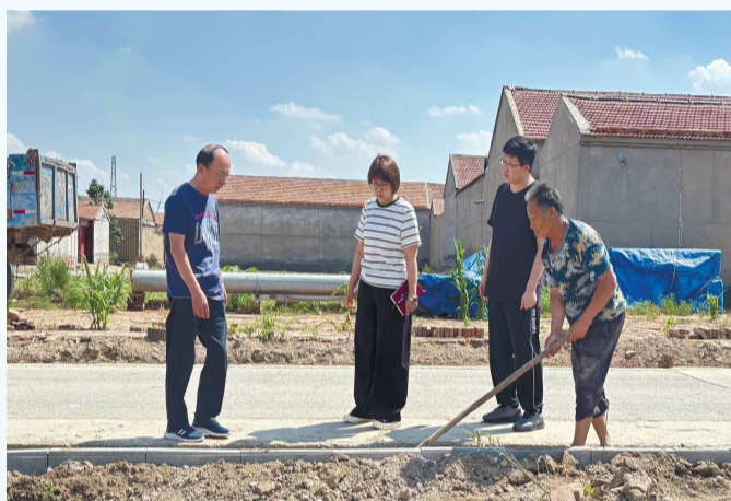
静海区沿庄镇纪委、监察组深入施工现场开展嵌入式监督,确保项目建设公开透明,规范高效。
