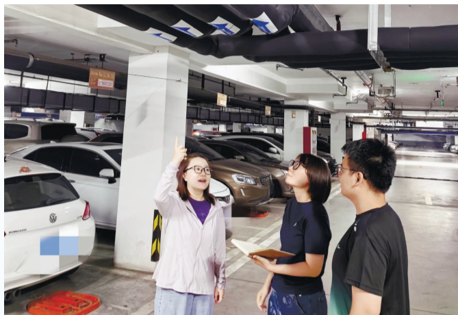
红桥区三条石街道纪检监察工委、北开花园社区纪检监察工作联络站监督推动自来水管改造工程顺利完工。
