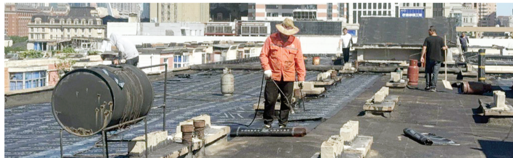
工人们给楼顶铺设防水毡布。
