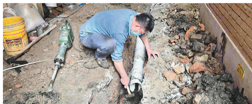
工程人员在地下管网改造。 受访者供图
