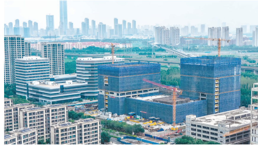
连日来,作为西青区智能网联车产业链的重点工程,位于张家窝镇的经纬恒润天津研发中心二期项目建设已进入主体结构冲刺阶段,预计9月30日完成主体封顶。
