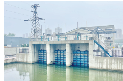
近日,作为我市2026年民心工程中防汛排涝项目之一的红星桥泵站站建设工程完工。该泵站位于月牙河与新开河交汇处,投用后可实现防洪安全与水生生态修复双重目标。
