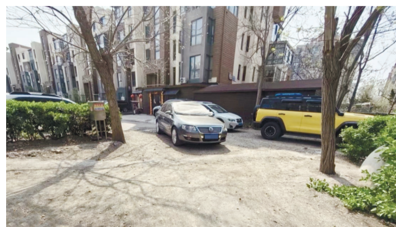
新新家园小区树木和绿地缺乏养护,导致黄土裸露、树木枯死。
