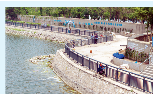
近日,滨海新区塘沽老码头公园升级滨水安防设施,开展海河岸边护栏加装作业,保障游客游园安全,工程计划于本月底完工投用。 记者 赵建伟 摄
