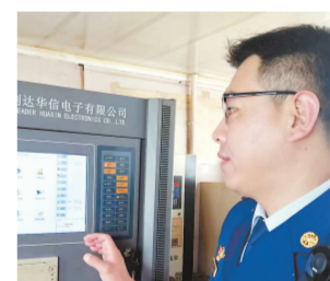
消防监督员检查消防报警设备。
