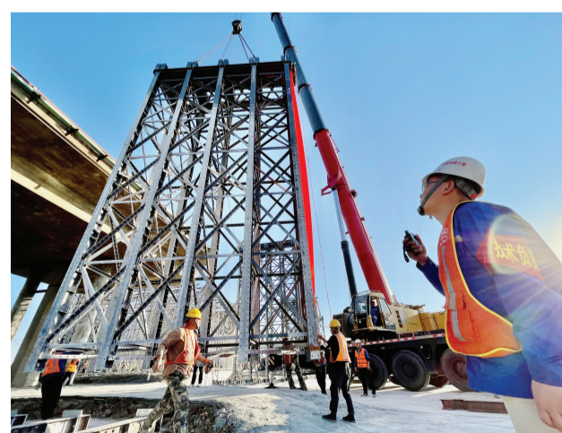
“五一”假期,中铁六局天津公司近百名建设者坚守在津沧高速改扩建工程施工现场,进行跨铁路旧桥梁的整体拆除工作。 记者 张磊 摄
