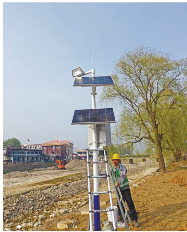
施工人员布设应急通讯设备。照片由受访单位提供
