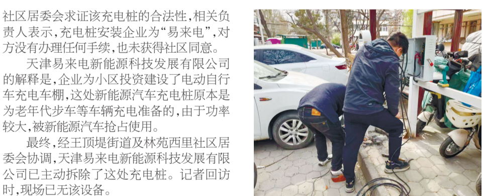
工作人员正在拆除充电桩。
