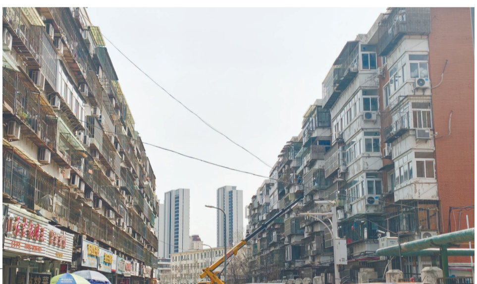
程林里违规引出的电线横跨主干道。
