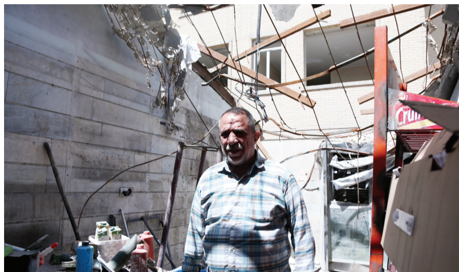
4月14日,在伊朗首都德黑兰东南部一处居民区,当地居民雷扎·扎雷站在遭美以袭击严重受损的自家店铺前。美以袭击给居民区造成人员伤亡和严重财产损失,当地居民强烈谴责。
