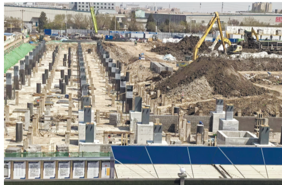
泰达电力长时储能电站项目正在加快建设。
