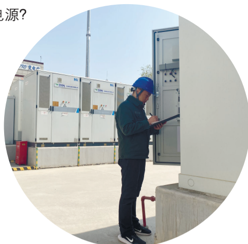
泰达电力工作人员在电网侧电化学储能电站巡检。
