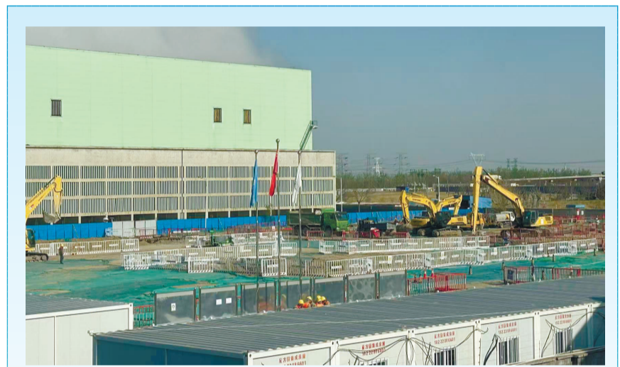
陈塘热电共享储能电站项目正在开展土建作业。
