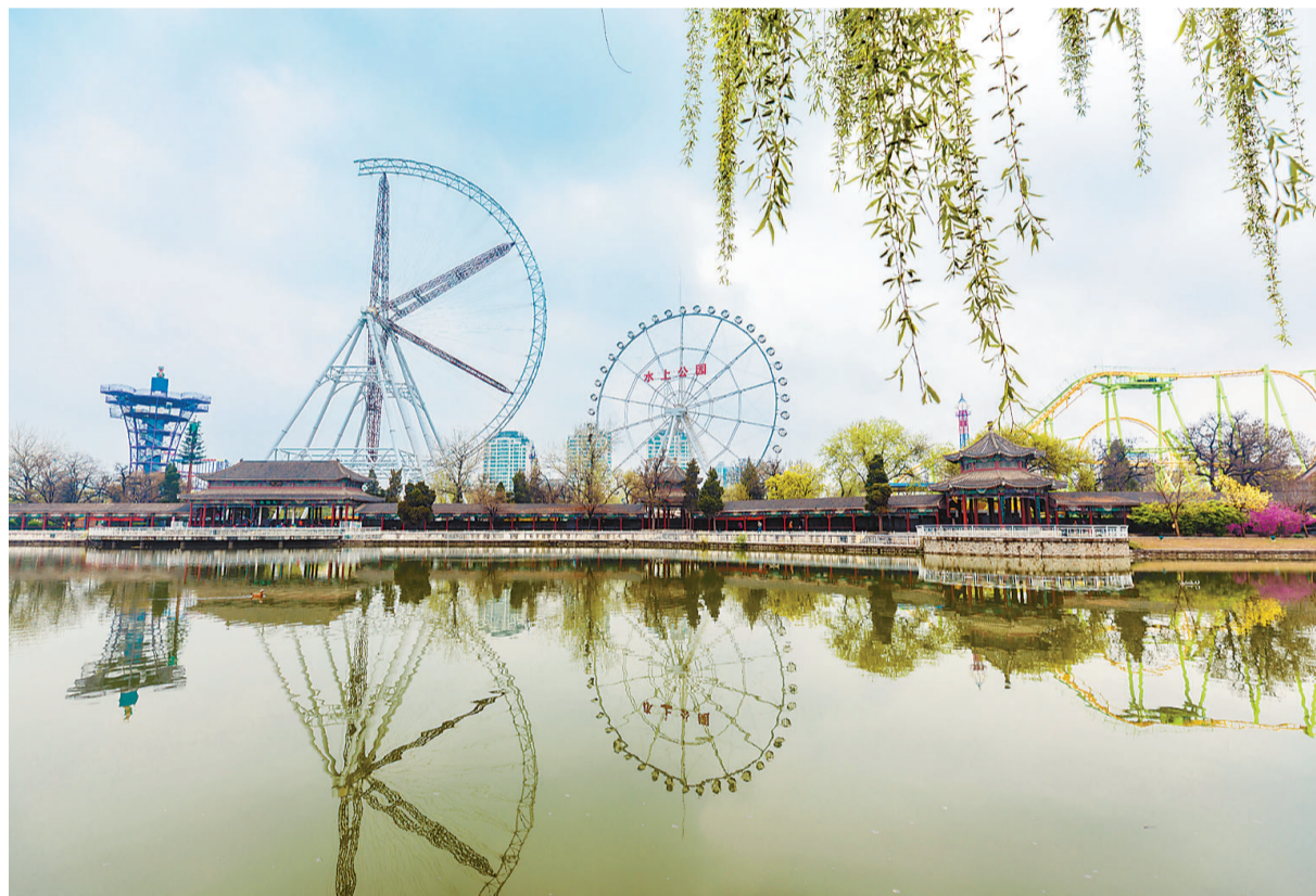
昨日,水上公园新建的88米高摩天轮正在进行主体结构立架与轮盘安装。据了解,该摩天轮设有36个吊厢,可同时载客200余人。 记者 赵建伟 摄
