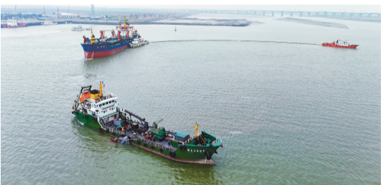
近日,天津港大港区10万吨级航道提升工程全速推进海上疏浚施工。 通讯员 郑倩 摄
