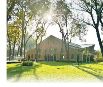
更新改造后的天津第一机床总厂部分建筑
