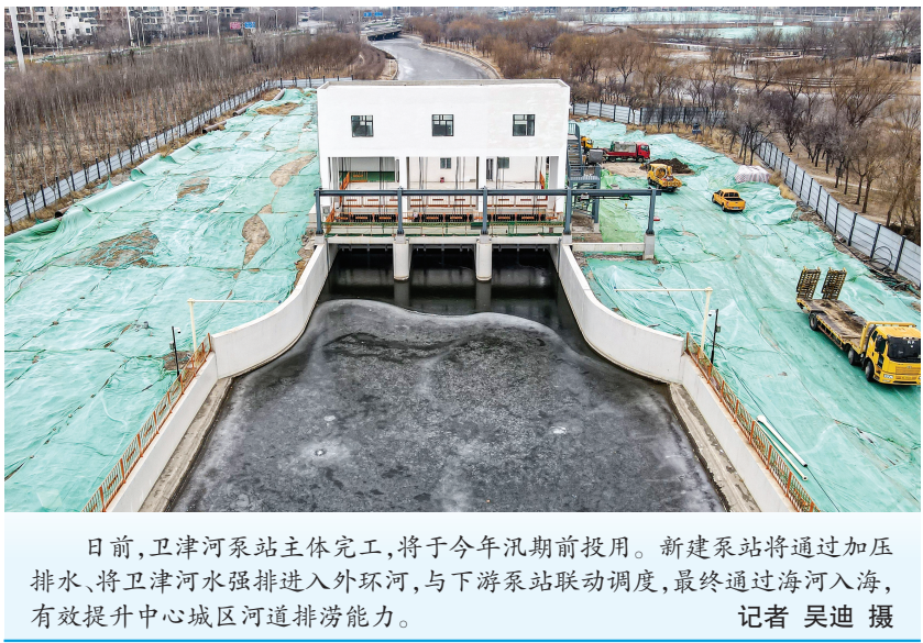
日前,卫津河泵站主体完工,将于今年汛期前投用。新建泵站将通过加压排水、将卫津河水强排进入外环河,与下游泵站联动调度,最终通过海河入海,有效提升中心城区河道排涝能力。
