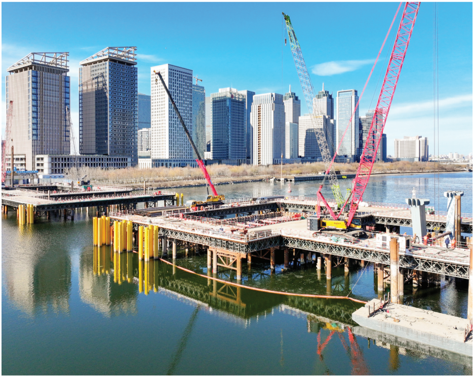
滨海新区安阳桥、于新桥“两桥”项目建设迎新进展。安阳桥顺利完成于家堡侧承台等下部结构施工;于新桥完成大沽侧主墩封底施工,正式转入主墩承台施工阶段。图为安阳桥项目施工现场。记者 赵建伟 摄
